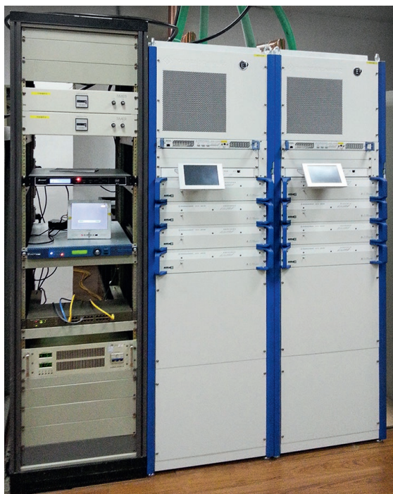
Dos de los transmisores de TV de alta potencia R&S®THU9 refrigerados por líquido que llevan la televisión digital a la provincia de Hunan en el sur de China.
