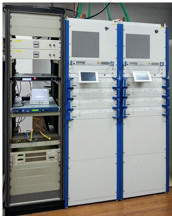
Zwei der flüssigkeitsgekühlten TV-Hochleistungssender R&S®THU9, die die südchinesische Provinz Hunan mit digitalem Fernsehen versorgen.
