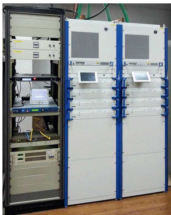
Deux des émetteurs TV R&S®THU9 de forte puissance refroidis par liquide qui alimentent la province de Hunan en TNT.
