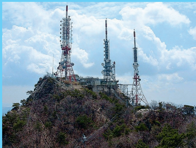
Les premiers programmes 4K terrestres du monde sont diffusés via la tour d'antenne de KBS (à gauche).
