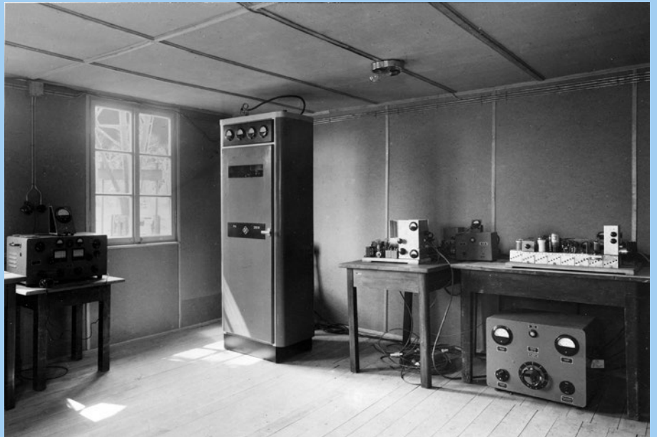
Der erste kommerzielle VHF-FM-Sender in Europa ging am 28. Februar 1949 in Betrieb. Geliefert hat ihn Rohde&Schwarz. Das Foto wurde im 16 m 2 großen Holzhäuschen des Bayerischen Rundfunks aufgenommen, das am Fuße des Antennenturms in München-Freimann stand.
