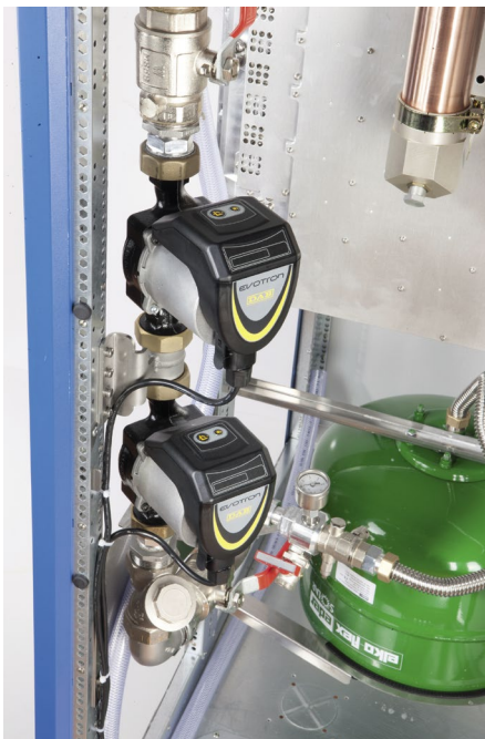
BILD 2: Redundante, integrierte Pumpenmodule für die Kühlung von Einzelsendern bis 20 kW.
