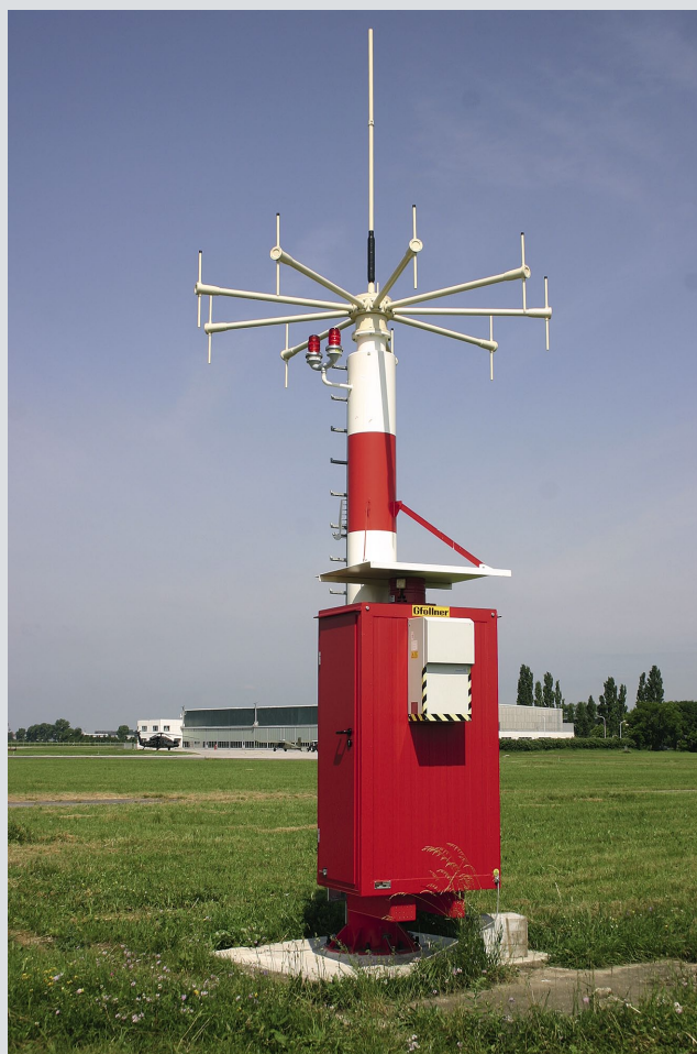
Fig. 2 Le radiogoniomètre R&S®DDF04E de la base aérienne Brumowski. Une armoire outdoor située au pied du mât, isolée et entièrement climatisée, abrite les équipements et le serveur radiogoniométriques.
