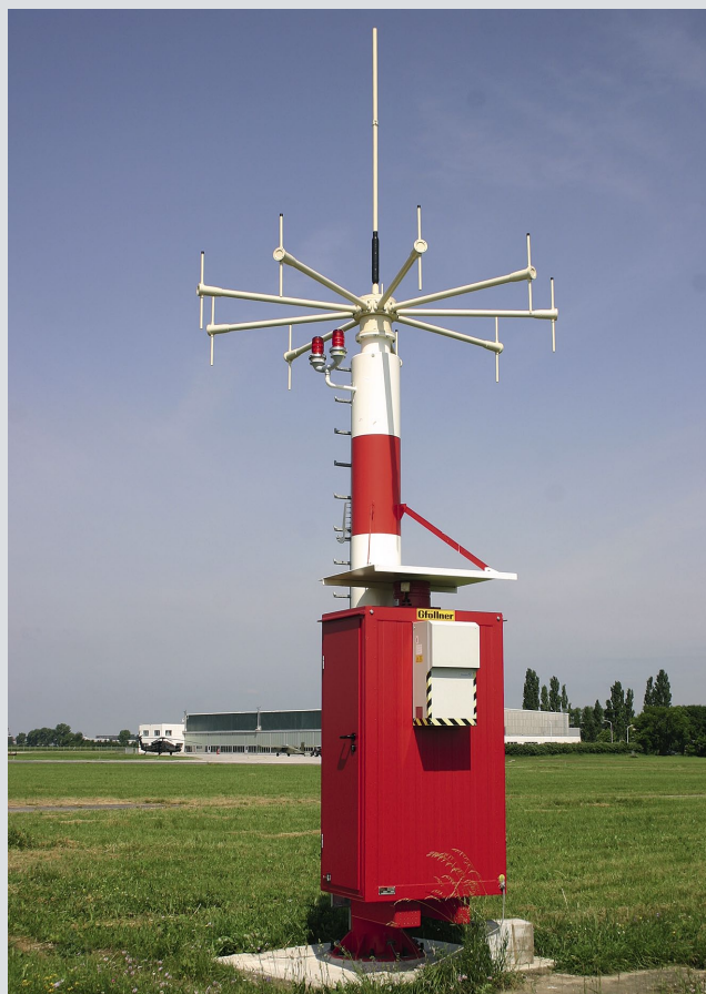
FIG. 2 Radiogoniómetro R&S®DDF04E en la base aérea Brumowski. Un armario aislado instalado al pie del mástil, para intemperie y completamente climatizado, contiene los equipos y el servidor de radiogoniometría.
