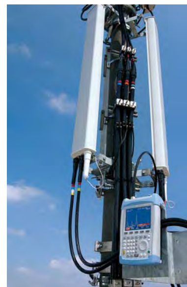
BILD 8 Der R&S®FSH3, ein Komplettmessgerät für die Installation und die Wartung vor Ort, bei Messungen an einer Mobilfunkantenne.
