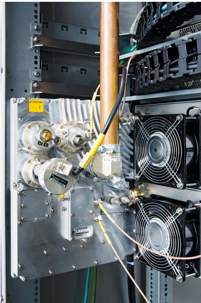
6-in-1-Kopplereinheit, für die Kopplung von zwei R&S®PMU901 Verstärkern.
