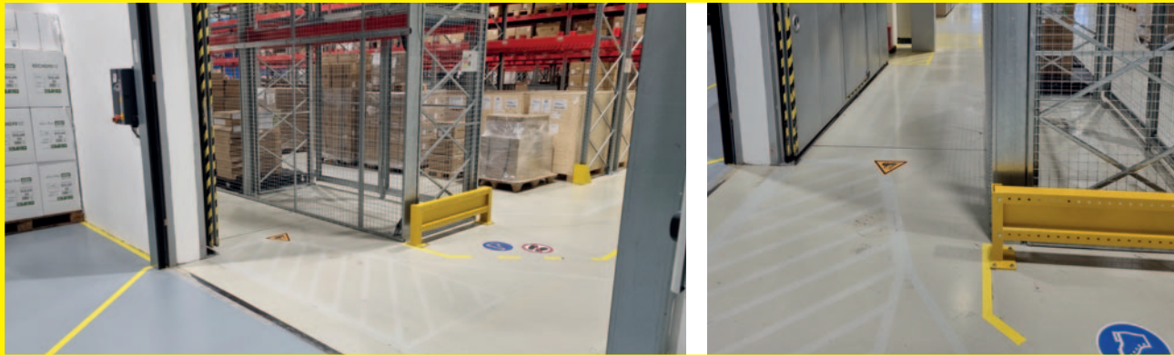
Ulička na M31 za regály u elektrorozvodny
