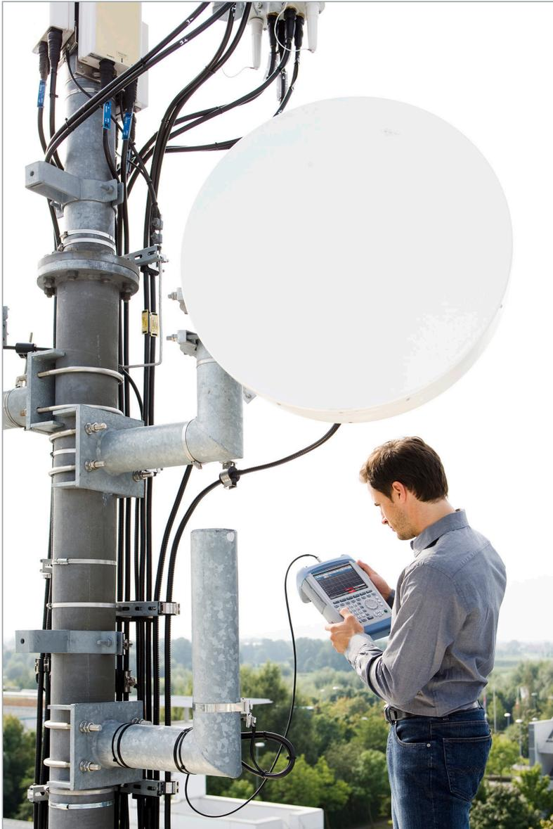
Le R&S®FSH en cours d'utilisation pendant l'installation et la maintenance de stations émettrices
