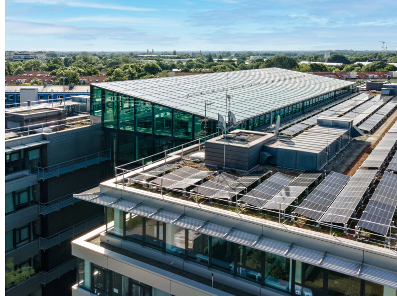
Die Photovoltaikanlage am Standort München liefert erneuerbaren Strom in Innenstadtnähe.
